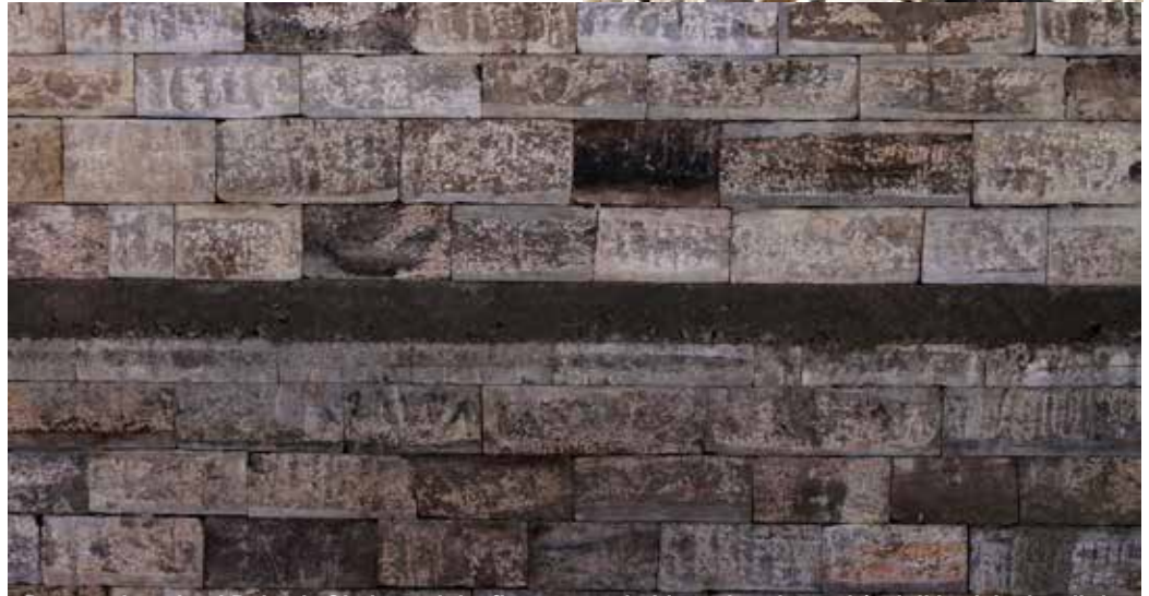
Den nye bygning i Bakanje Skole med det flotte stearbejde og jern-beton bånd til jordskælvsikring.
