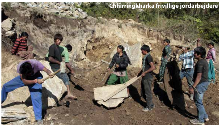
Chhiringkharka frivillige jordarbejdere
